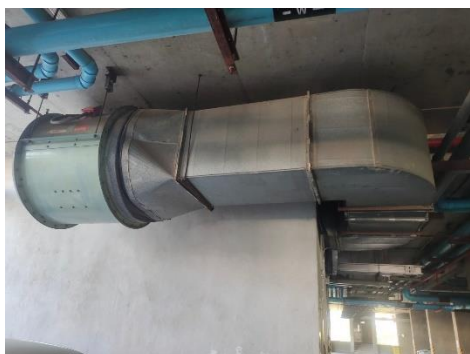
รูปที่ 10 พัดลมอัดอากาศเข้าโรงลิฟต์ดับเพลิง
